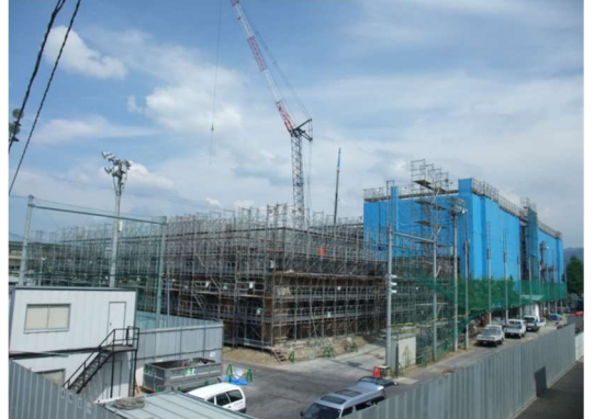
校舎の建設（平成23年3月24日竣工）
